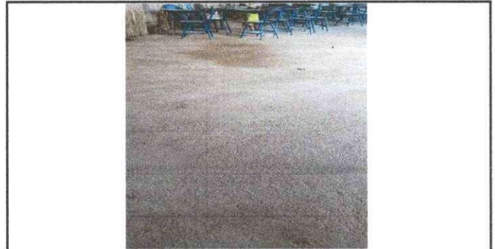
Foto 6: Se observa que la torta de cemento es rustica
