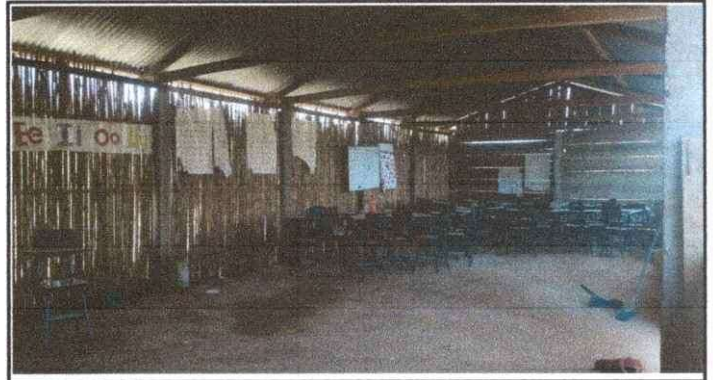
Foto 2: Se observa la estructura portante
